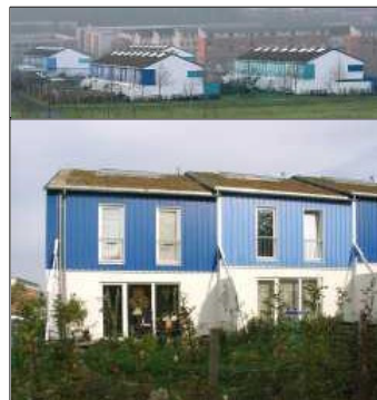
Schéma. 4 Statistique de consommation pour le lotissement maison passive de Kronsberg à Hannover: le lotissement de 32 maisons passives a été terminé en 1999. La consommation moyenne la troisième année (2001/2002) était de 12,8 kWh/(m²a). Le besoin calculé selon le [PHPP] correspond à 13,5 kWh/(m²a). (Remarque pour qui est féru de mathématique 2 )
