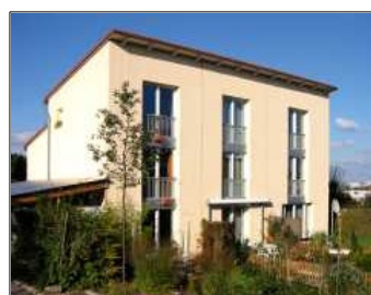
Abb. 5 Statistique de consommation pour le lotissement maison passive de Stuttgart/Feuerbach: le lotissement de 52 maisons passives a été terminé en 2000 (bureau d'architecture Rudolf). La consommation moyenne était de 12,8 kWh/(m²a). Le besoin calculé selon le [PHPP] de 13,5 kWh/(m²a) (Remarque pour qui est féru de mathématique 2 ).
