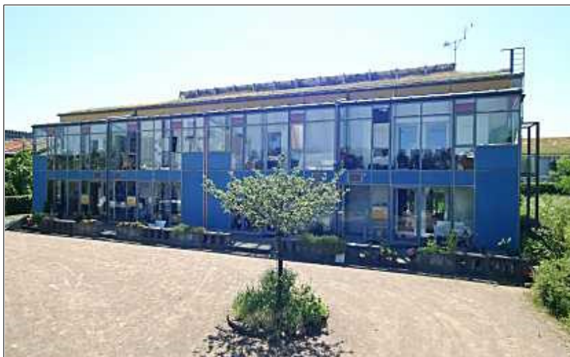
(2006: Vue de la maison passive de Darmstadt Kranichstein; Photo: Feist, 2006)
