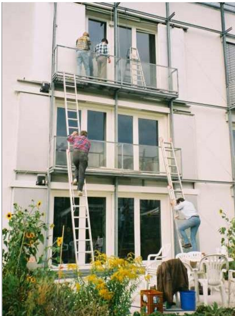
Montage des volets isolés en 1994
