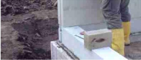
Sur le chantier, le montage des blocs de béton cellulaire sur le rang inférieur ne pose pas de difficulté. Sur la photo, on reconnaît une légère différence de coloration des blocs.
