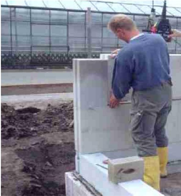
Dans une construction neuve, le montage des blocs de béton cellulaire en rangée inférieure est facile à mettre en oeuvre. Sur la photo, on reconnaît une légère différence de coloration des blocs.
