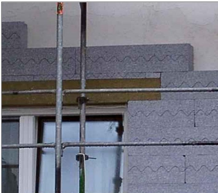
L'isolation de 20 cm sur la façade pendant la réalisation (rénovation Nuremberg Jean-Paul-Platz). Les plaques d'isolant sont collées sur le vieux crépi et dans la phase suivante seront recouvertes d'un nouvel enduit. Cette technique a largement fait ses preuves. Les économies d'énergie de cette rénovation "modèle" sont supérieures à 85% (voir "La rénovation").
