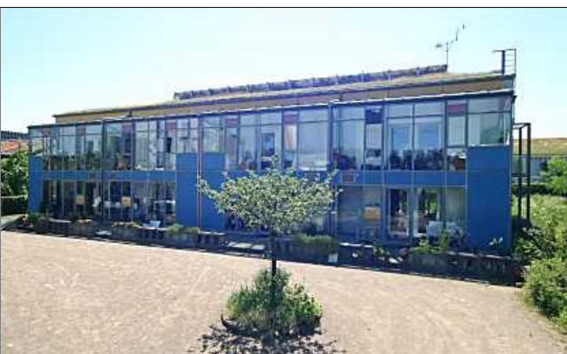
La maison passive Kranichstein à Darmstadt côté nord.
