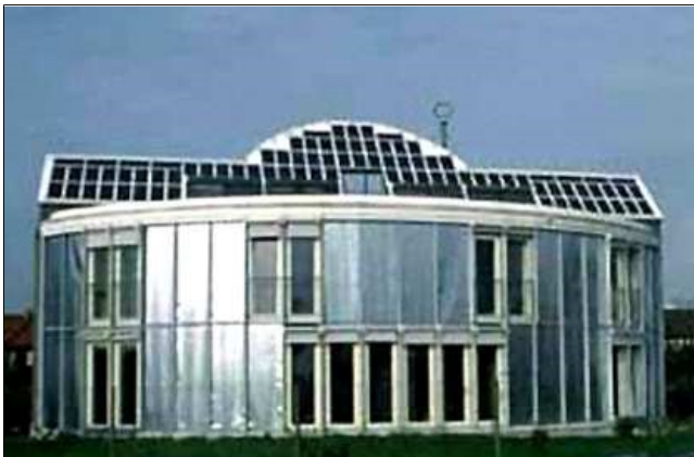
La maison solaire autarcique de l'ISE à Freiburg. Le bâtiment est aujourd'hui utilisé comme une maison passive.
