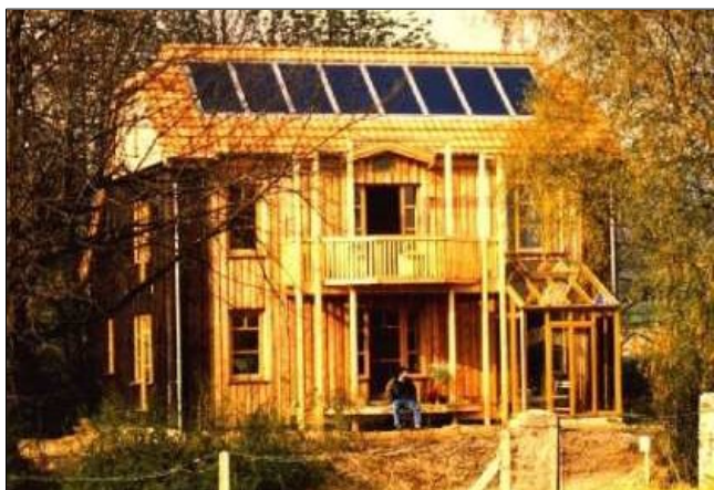
La maison énergie nulle à Dörpe du côté d' Hannover.
